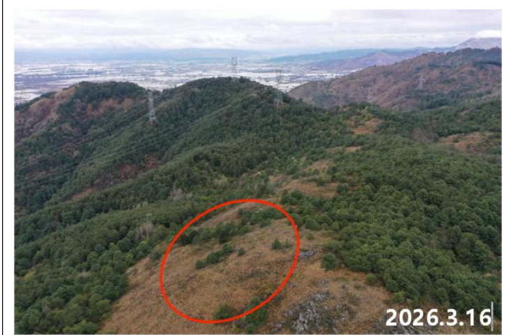
光伏列阵区（K12 片区）现状
