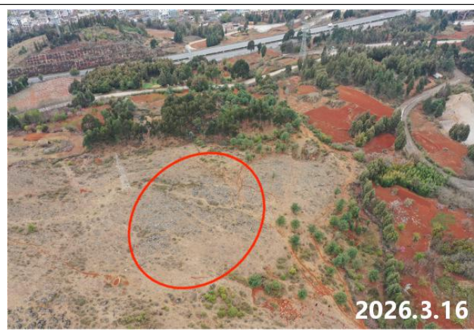
光伏列阵区（K3 片区）现状
