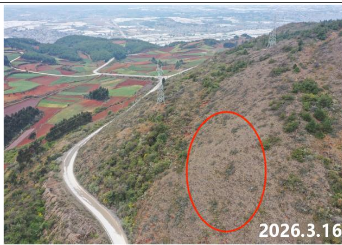
光伏列阵区（K2 片区）现状 2
