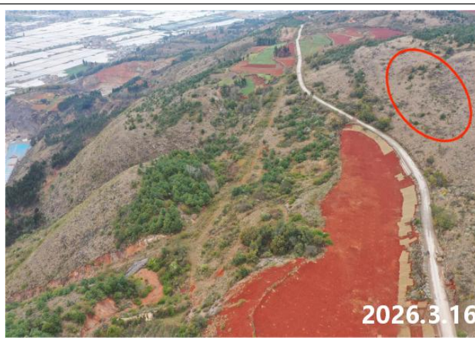
光伏列阵区（K1 片区）现状 2
