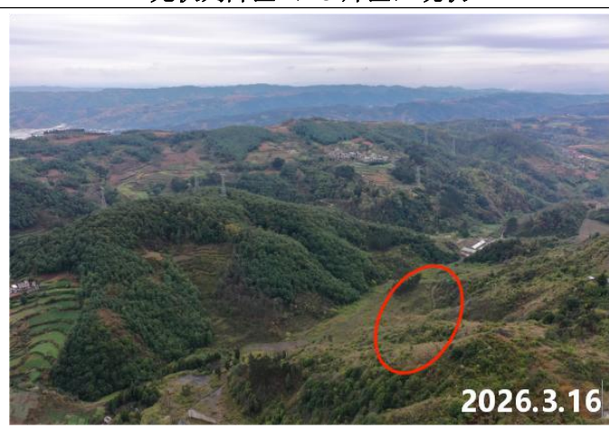
光伏列阵区（K5 片区）现状
