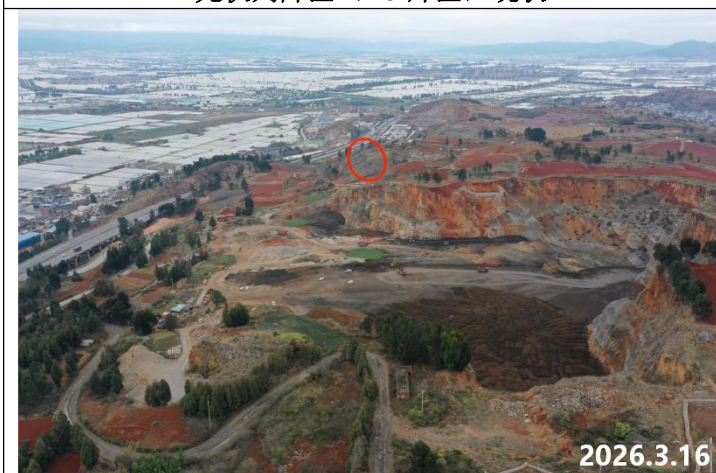
光伏列阵区（K4 片区）现状
