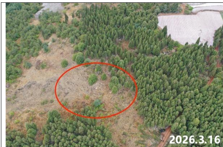
升压站厂址现状 1
