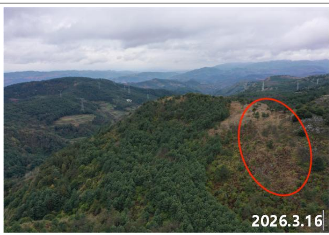
光伏列阵区（K11 片区）现状
