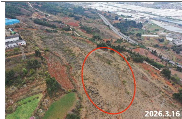
光伏列阵区（K3 片区）现状
