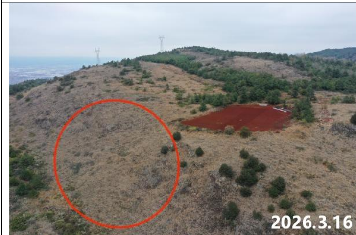
光伏列阵区（K2 片区）现状 1
