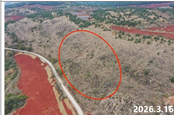
光伏列阵区（K1 片区）现状 1
