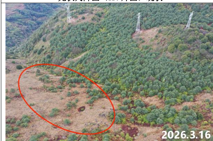
光伏列阵区（K6 片区）现状
