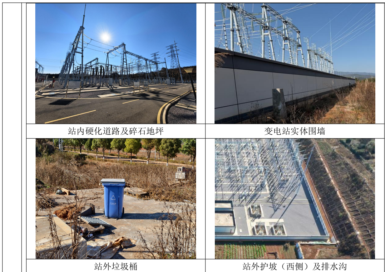
图5 220kV 向荣变电站实景照片
